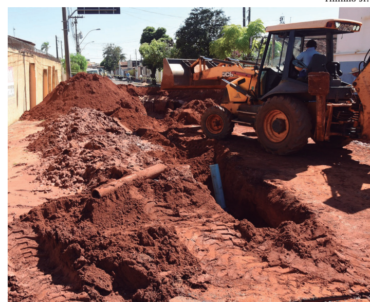
TRABALHO: Equipes do SAAE durante reparo no local
