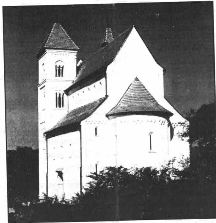
Evangelische Kirche in Mönchsdorf erbaut : 1100 -1200, renoviert und restauriert: 1998 - 1999
